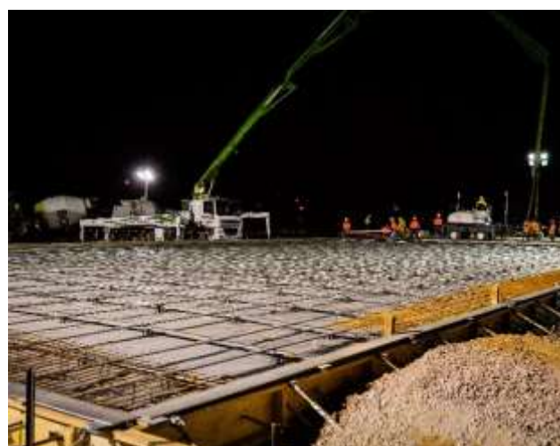
Concrete night pours
